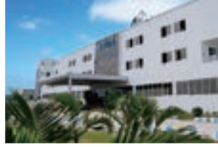
Rudrapur Fabrika (Yeşil Bina)
