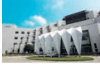
Tainan Fabrika (Elmas Sınıfı Yeşil Bina)
